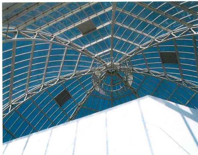
▲ドームの骨組には溶融亜鉛めっき鋼材がレストランも含めて 205トン使用されている
