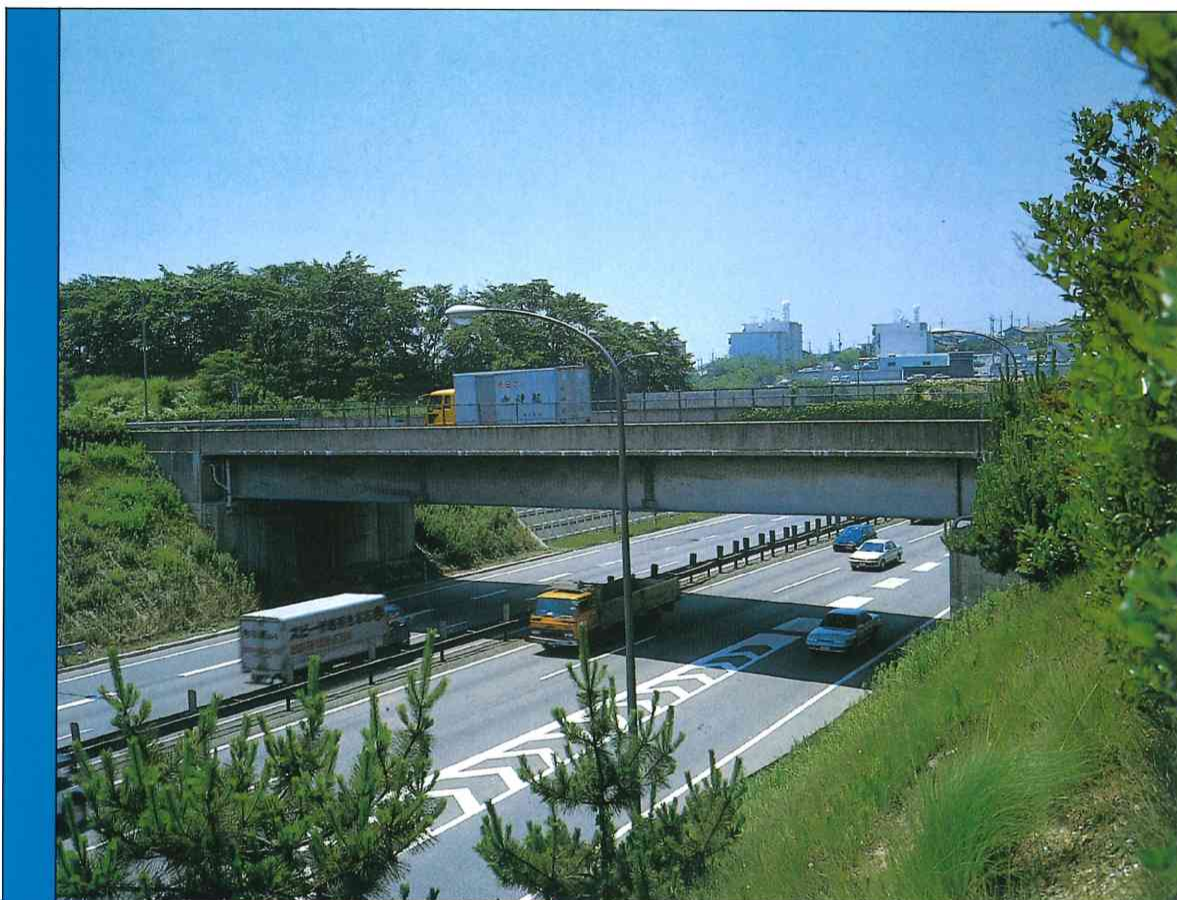
▲明石SA橋（第二神明道路） 昭和51年に溶融亜鉛めっきされた橋桁で、 現在でも安定した表面状態を保っております。
