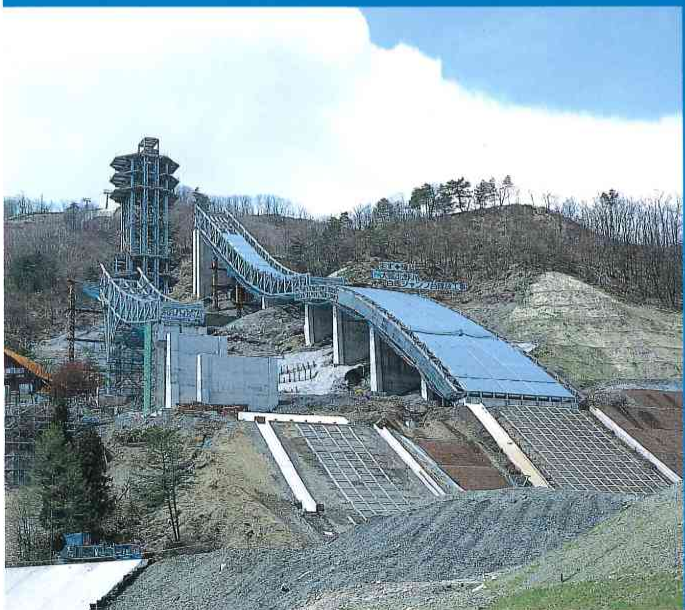
▲建設中のジャンプ台
