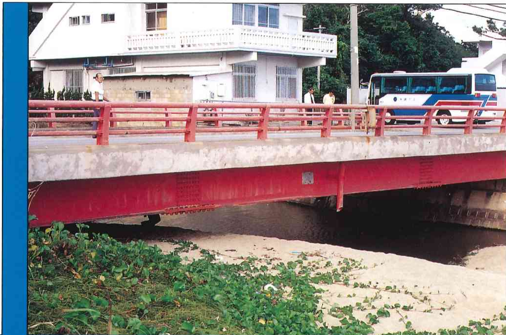
▲写真1 溶融亜鉛めっき後、塩化ゴム 2回塗り塗装された、沖縄県 の潮上橋
