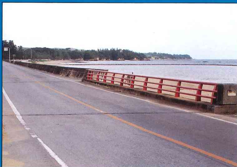
▲写真2 溶融亜鉛めっき後、塩化ゴム2回塗り、塗装さ れた潮上橋の高欄
