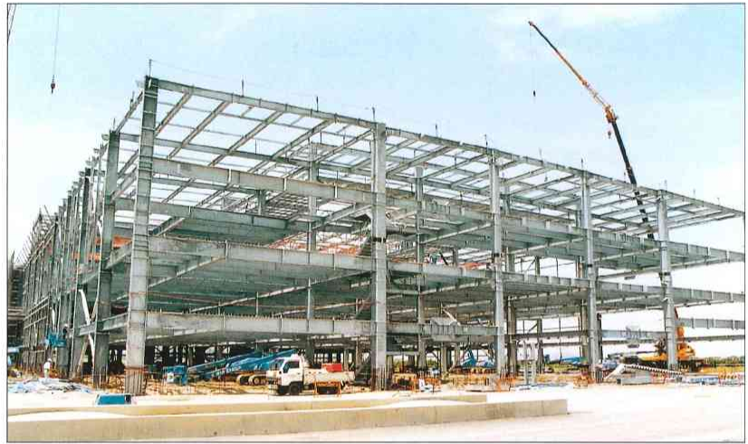
写真3 ▶ めっきコラム柱を主に 用いた建築物
