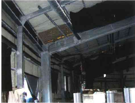
写真3. 海側入口付近
