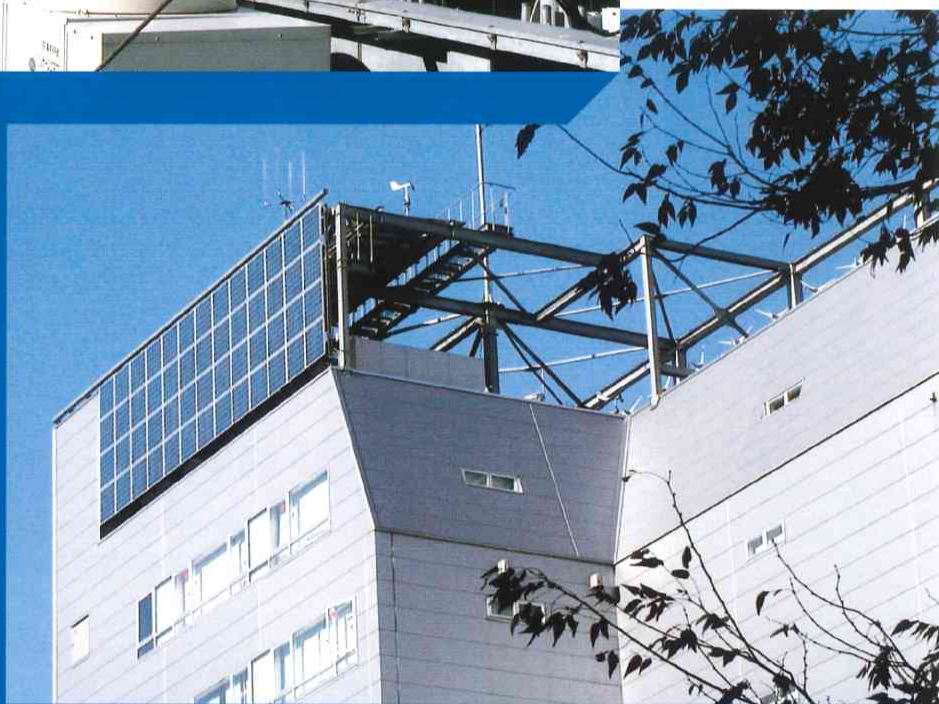
▲写真2 太陽電池パネル 鉄骨は溶融亜鉛めっきされている。 取材協力：永代橋エコピアザビル
