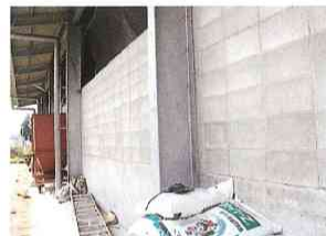
写真3 養生棟外部H柱
