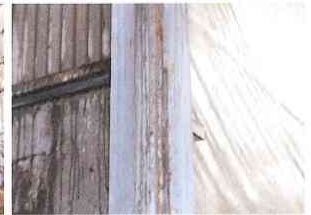
写真2 発酵室棟H柱
