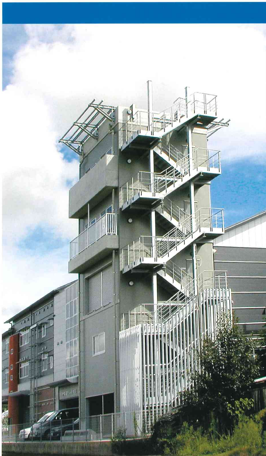
高知県南国市総合消防庁舎の訓練塔用階段
