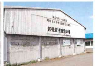
写真4 製品貯留棟外部H柱
