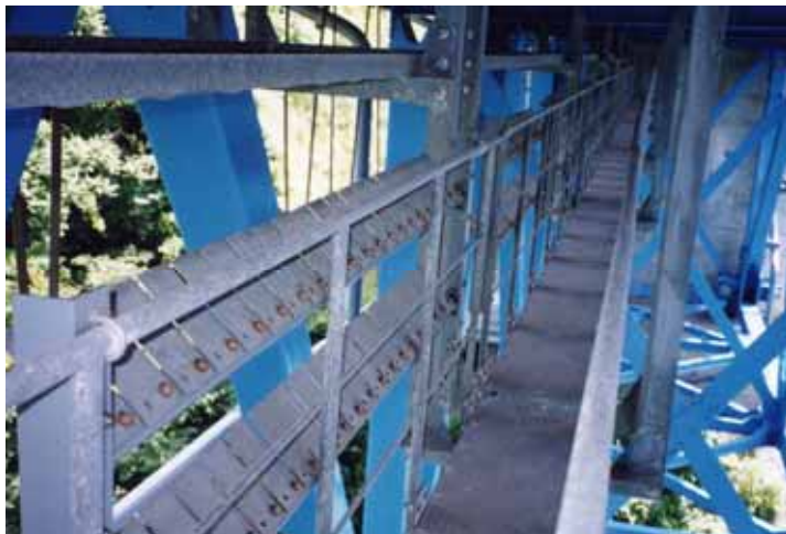
写真 1. 暴露試験片設置状況
