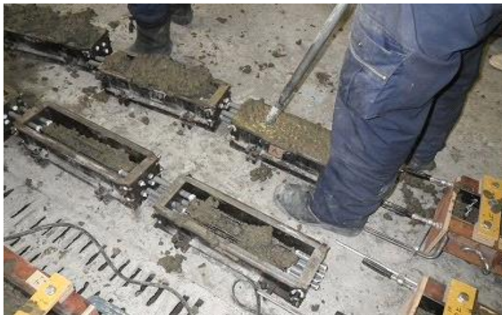
(b) コンクリート打設状況
