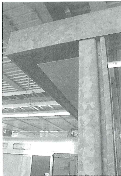
図9 低明度・低光沢処理を行った近代建築物 （左：過マンガン酸処理 右：リン酸亜鉛処理）
