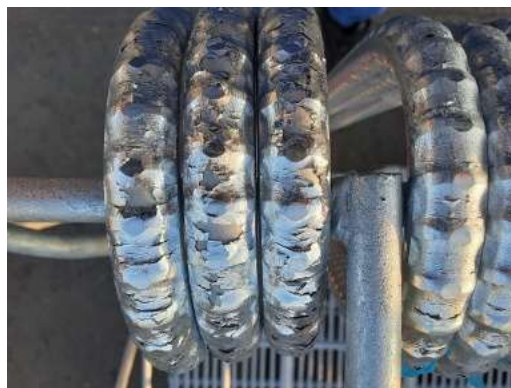
写真 4.3.1 亀裂や剥離を生じた鉄筋
