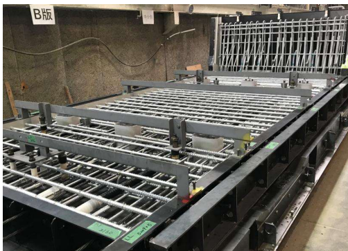
配筋後の状況
