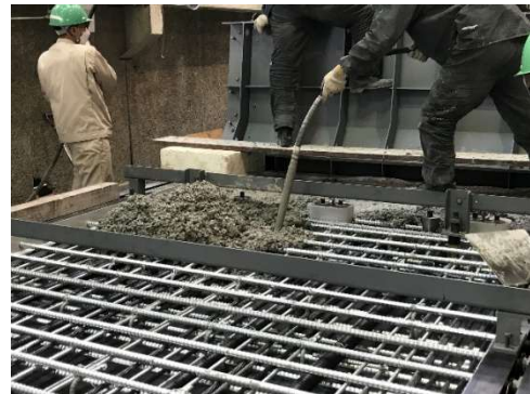
コンクリート打設時
